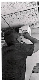
Cambio de control del mini split
