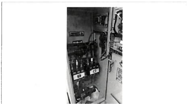
Cambio de "PLC's"
