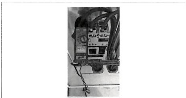
Medición de amperaje en el sistema
