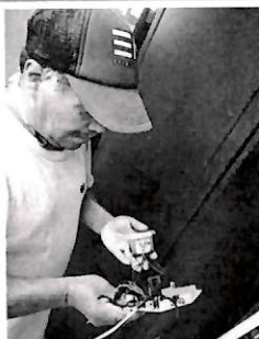
Remplazo de tarjeta del mini split
