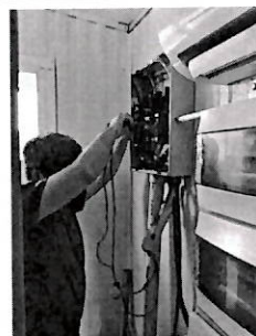
Cambio de cableado eléctrico y medición de voltaje
