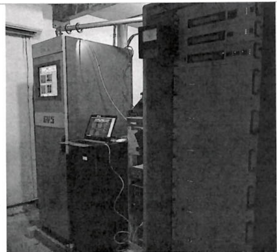
Quedaron conectados ambos transmisores para que trabajen como principal y el segundo como auxiliar en caso de problema del principal.
