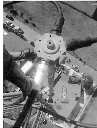
Se desconectan los conectores, se les retira humedad, se limpian correctamente y se aprietan conexiones.
