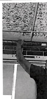
Cambio de filtros guarda polvo
