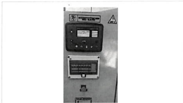
Cambio de medidor de tablero
